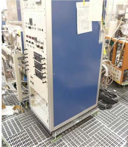
装置をグレーティングとその下の鉄骨の両方に固定。長ボルトは、グレーティングの裏表、鉄骨に渡したアングル材の裏表でねじ留め。グレーティングには力分散板を取り付け。
