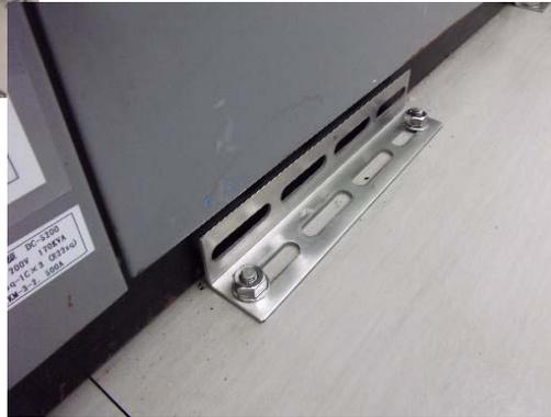
高周波電源に穴をあけるのが困難であったため、L字金具で平行移動を阻止。重心の低い装置で、べた置きのものには有効。→
